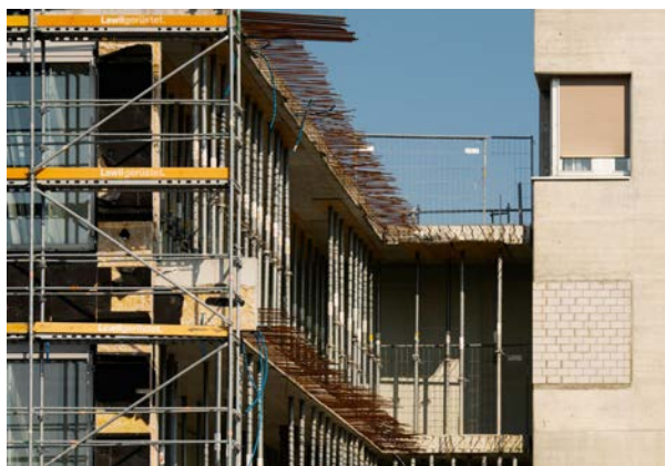
Auf der Baustelle für den Neubau des Spitals stehen die Arbeiten seit geraumer Zeit still. Annick Ramp / NZZ
